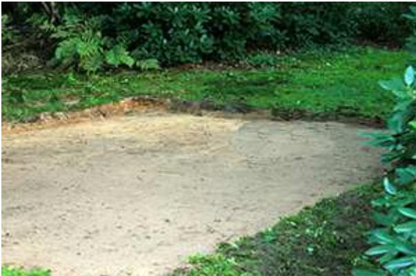
Eine weitere Alternative einen Bouleplatz zu bauen wollen wir hier ebenfalls noch erwähnen. Nach dem vorbereiten der Grundfläche, (hier genügte nach dem entfernen der Grasnarbe ein Auskoffern von ca: 15 cm, (gleich 2-3% Gefälle zur späteren Entwässerung berücksichtigen), wurde nur eine Schicht [Glensanda](#) 0/5 mm Körnung, in einer ca: 6 cm dicken Schicht, verdichtet ca: 4cm, eingebracht. Vor Einbringung des
