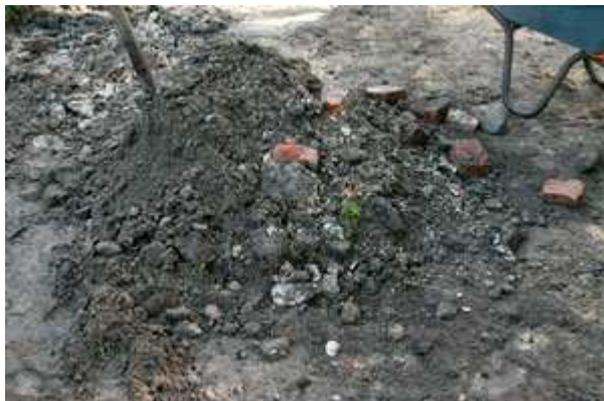
Die für den Boule-Platz vorgesehene Fläche wurde in diesem Beispiel ca. 25 cm ausgekoffert, hierbei gleich auf ein Gefälle von etwa 2-3% achten dies dient später der besseren Entwässerung. Der Aufbau der Spielfläche erfolgte mit Hartstein-Schotter 2/32 ca. 15 cm, darauf die nächste Schicht, Hartstein-Schotter 0/16 ca. 6 cm, mit einer Schaufel gleichmäßig verteilen, eventuell auch mit einem kleinen Bagger. Nun das Ganze noch leicht nachwässern, aber
