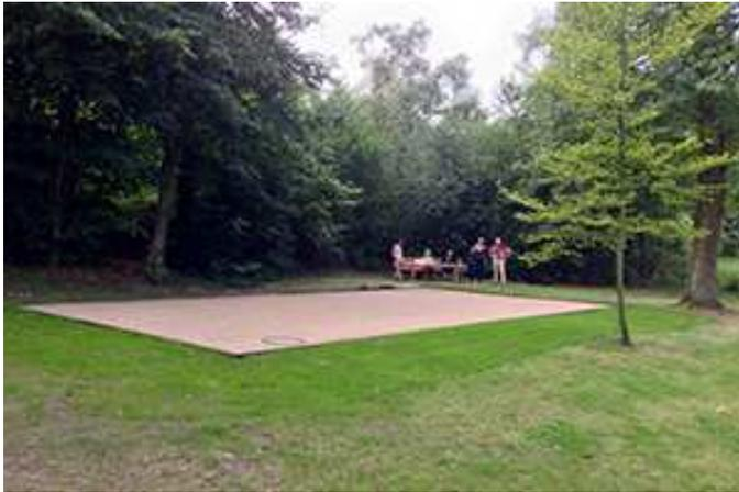
Nach ausgiebiger Suche und Lesen von Erfahrungen die andere „Bouleplatzbauer“ gemacht haben sind wir auf folgendes Material gestossen. Der Aufbau setzt sich aus einer Schicht von ca. 12 cm Hartsteinschotter 2/32, einer ca. 5 cm Grund-Schicht „HanseMineral 0/16“ und einer Deckschicht von ca. 3 cm „HanseGrand 0/5“ zusammen. „HanseGrand“ besitzt alle Eigenschaften die unsere Anforderungen an einen robusten, mit
