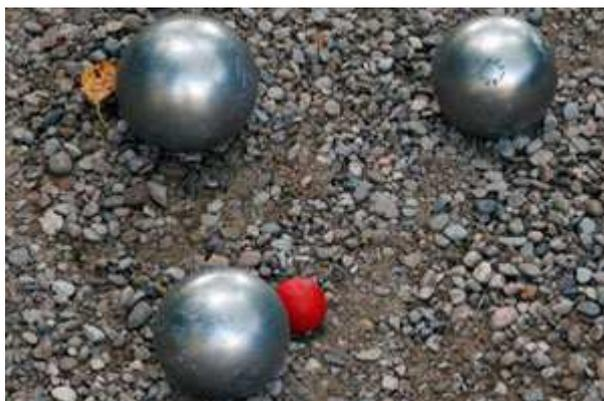
Das Material der Deckschicht kann aus einem Brechsand-Splittgemisch, aus Glensanda oder aber auch aus Hanse-Grand bestehen, (hierzu siehe weiter unten!). Deckschicht ca. 6 cm, (verdichtet ca. 4 cm) Körnung 0/5 oder wenn man es gröber möchte 0/8, wichtig ist das die Deckschicht gleichmäßig verteilt und verdicht wird, am Besten mit einer Walze. Hier auf keinen Fall einen Rüttler verwenden. Nun noch
